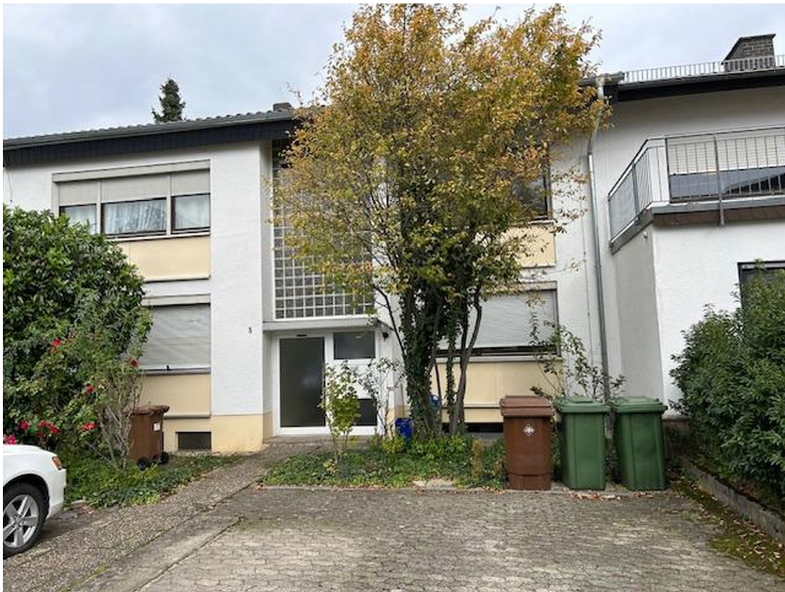
Hauseingang von Westen
