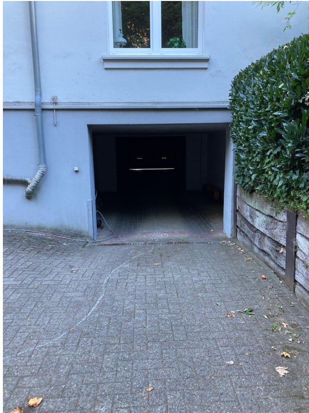
Durchfahrt zum Carport
