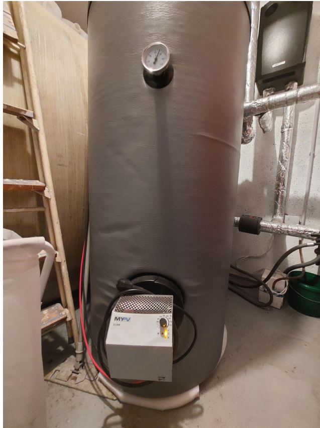
PV-Heizungsunterstützung
