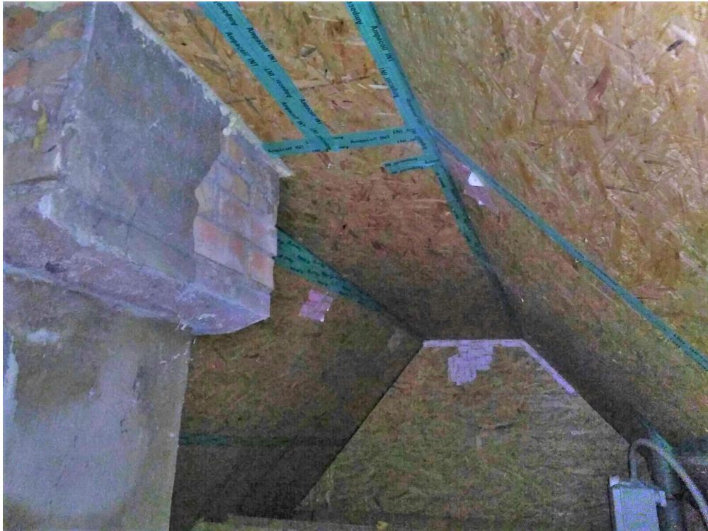
Dachisolierung
