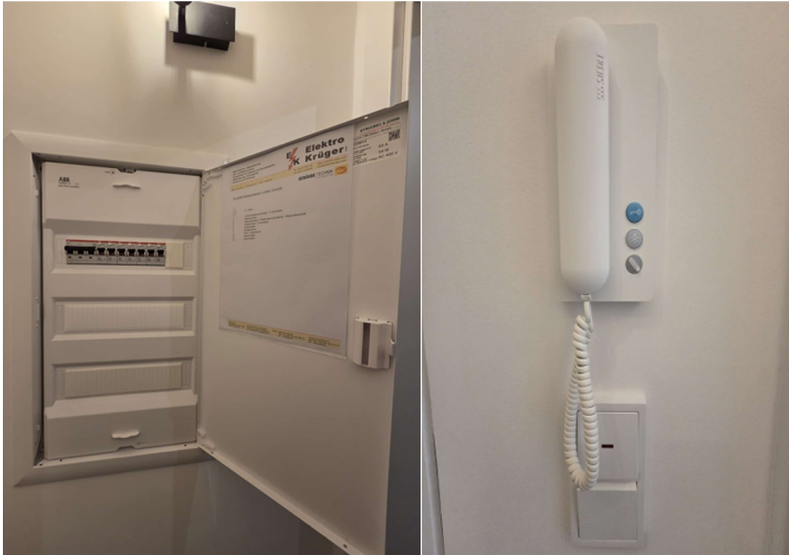
Sicherungskasten und Türöffner
