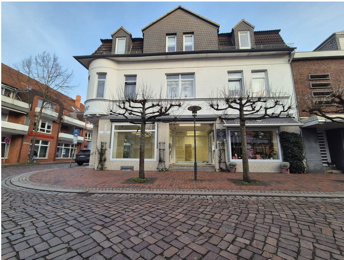
Gebäudeansicht Lübecker Str.
