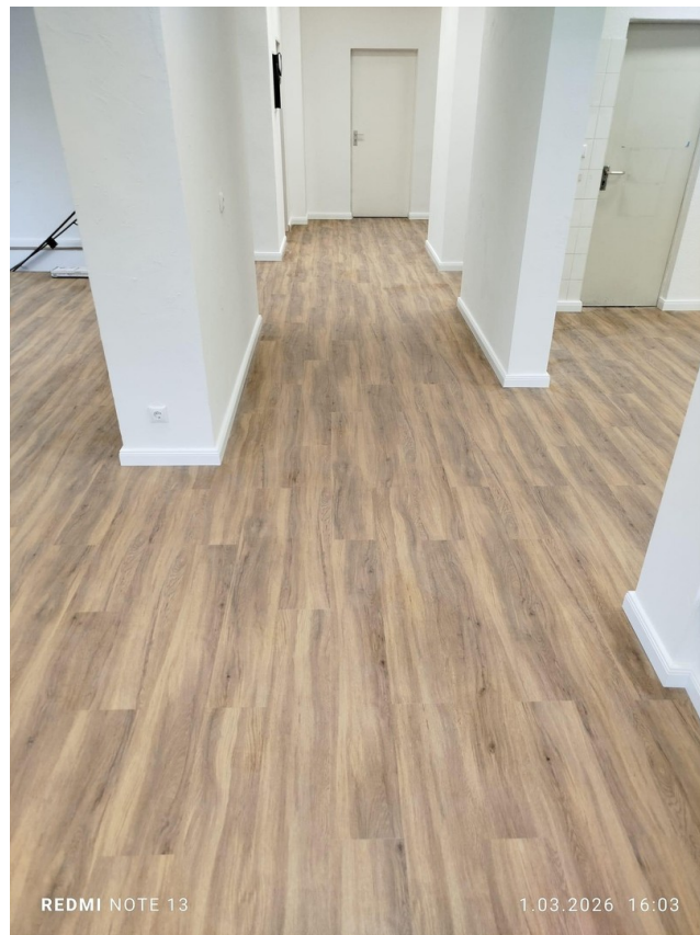
Neuer Fußboden März 2026
