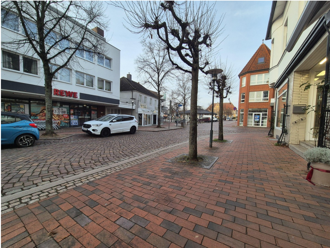
Gebäudeansicht Lübecker Str.
