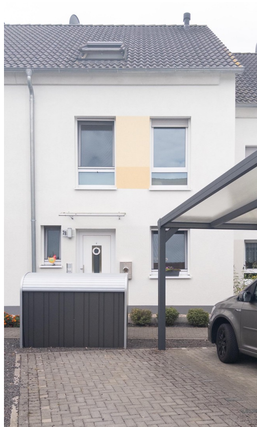
Ansicht von der Strasse
