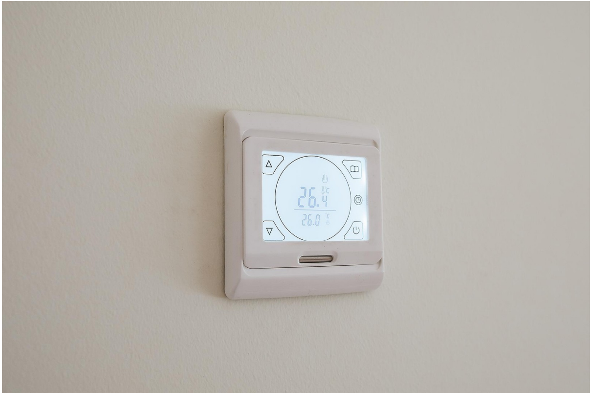
Regler Fußbodenheizung
