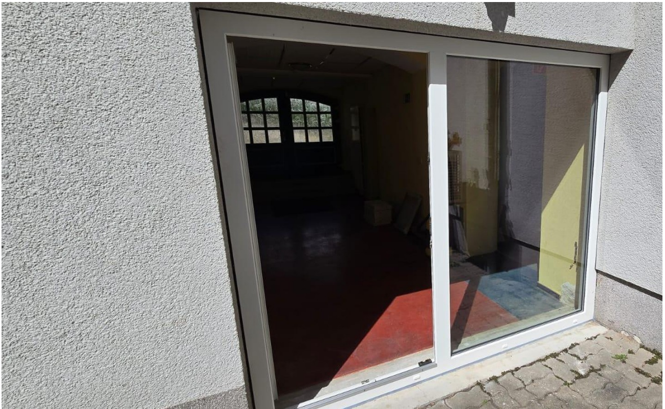
Blick von Terrasse in Flur
