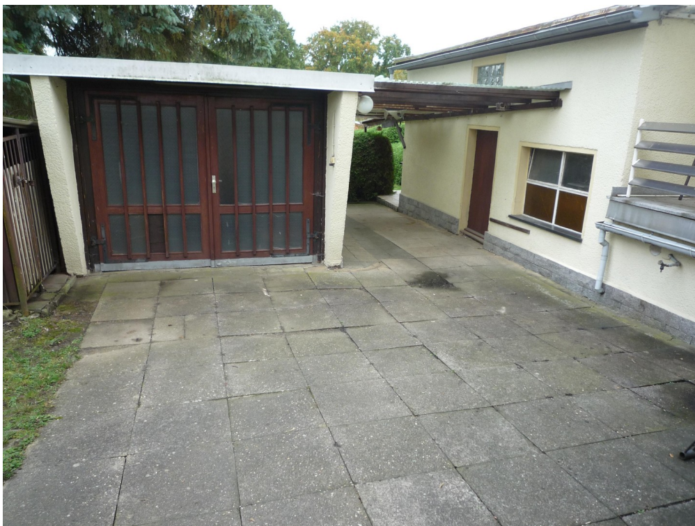
Garage und Hofbereich
