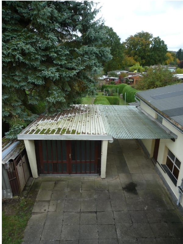
Blick auf Hof vom 1. OG
