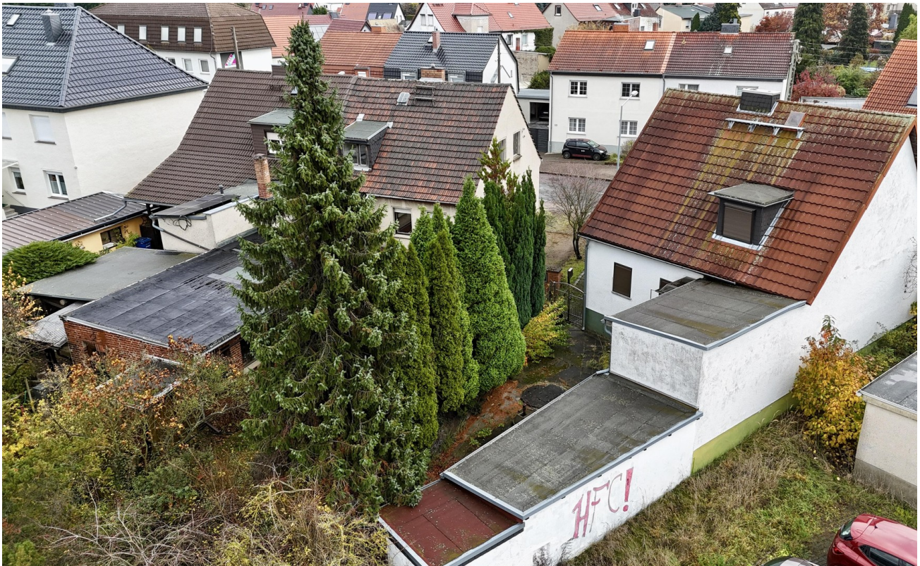
Von außen seitlich
