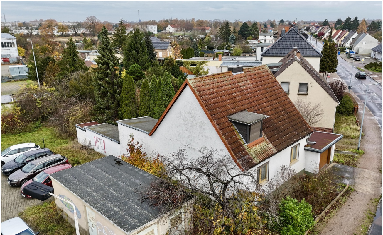
Von außen seitlich
