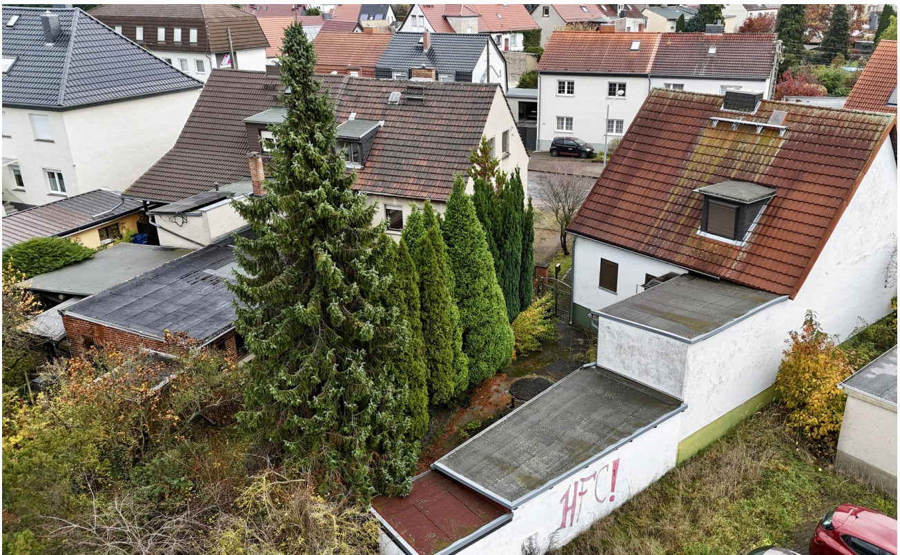
Von außen seitlich
