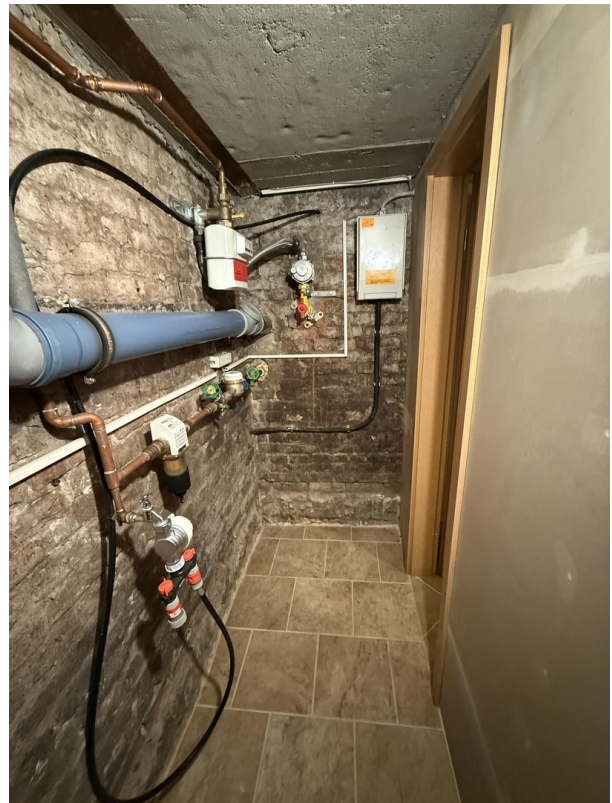
Zählerraum für Gas und Wasser
