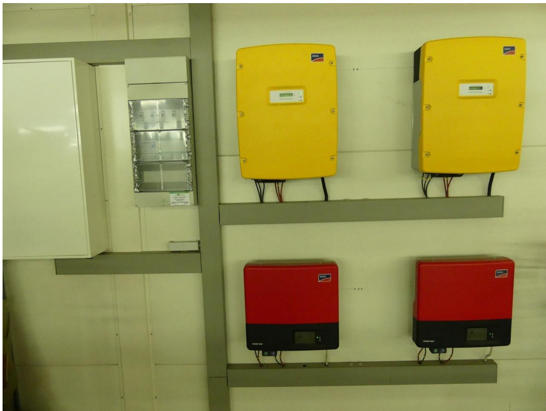
TKHaus PV-Wechselricht Döl-860
