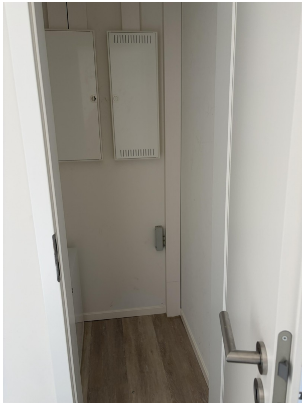
Abstellraum in der Wohnung
