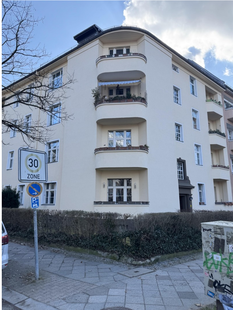
Ansicht Balkon Außen
