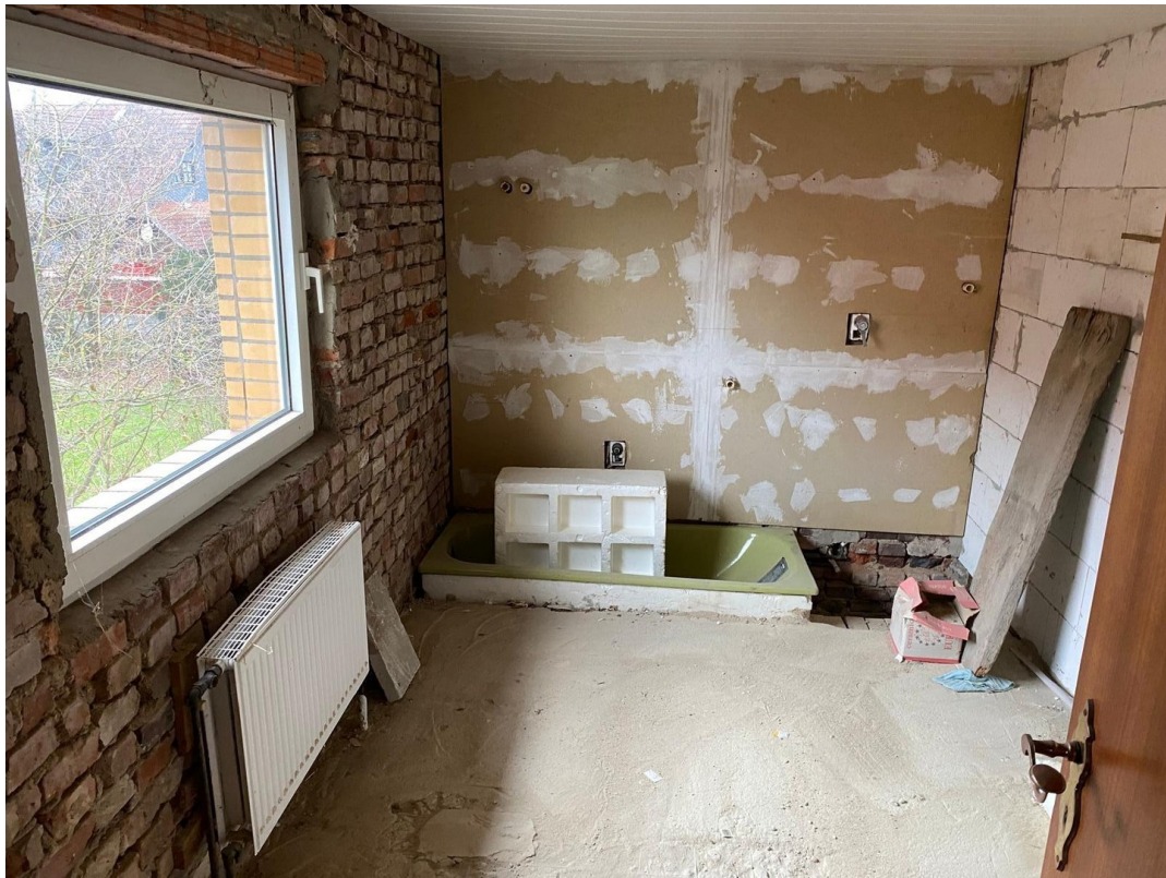
Zimmer über Anbau
