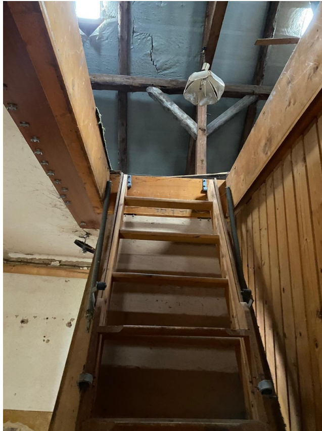
Treppe zum Spitzboden
