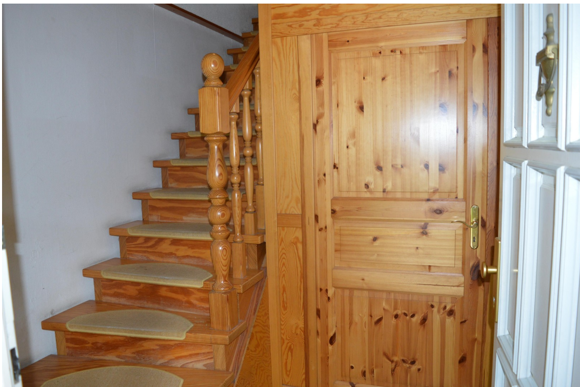
Treppe OG/ Flurtür EG
