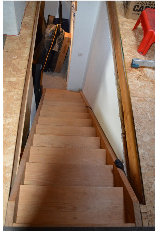
Treppe mit Blick vom DG zum OG
