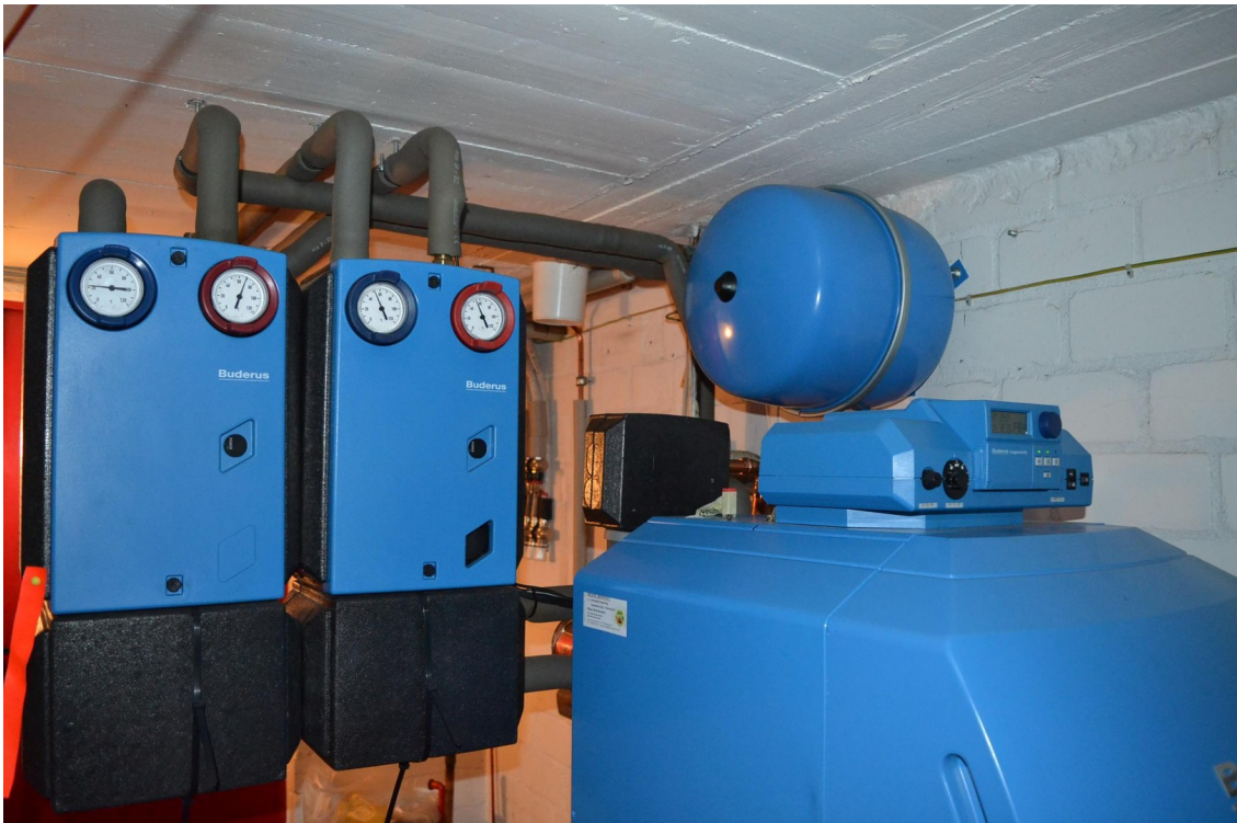
Moderne Brennwert-Heizung
