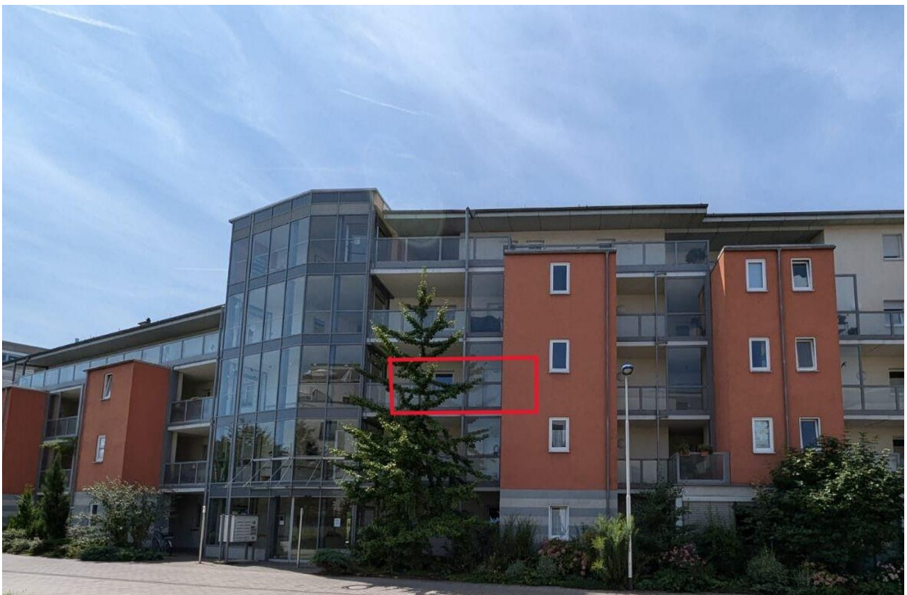
Wohnung von der Straßenseite
