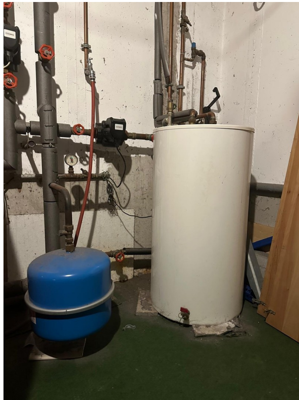
Warmwasserspeicher
