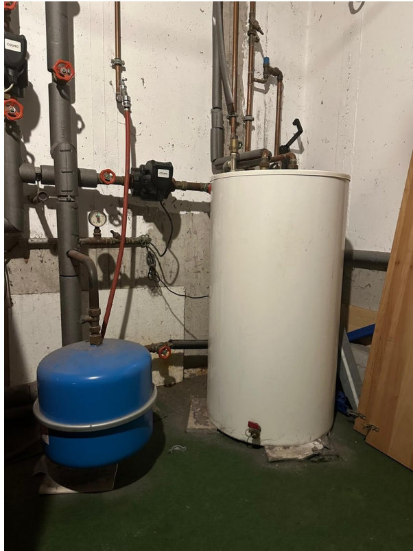
Warmwasserspeicher
