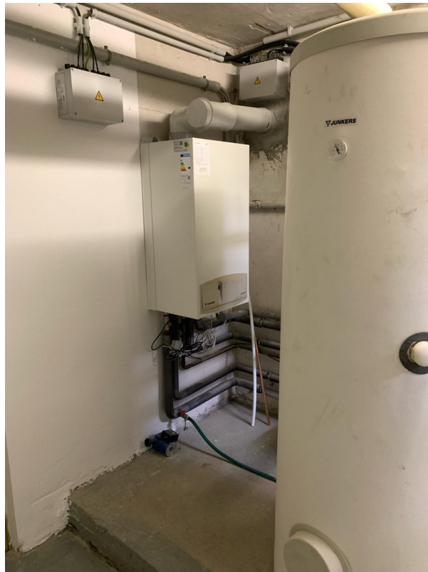
Junkers Brennwertkessel
