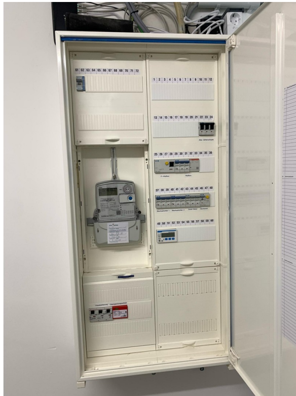
E-Kasten PV-Anlage
