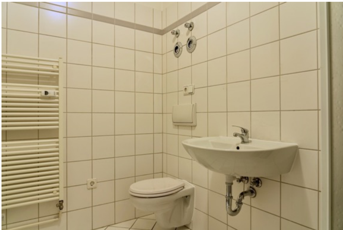
4. OG Foto Badezimmer mit neuer Toilette und Waschbecken
