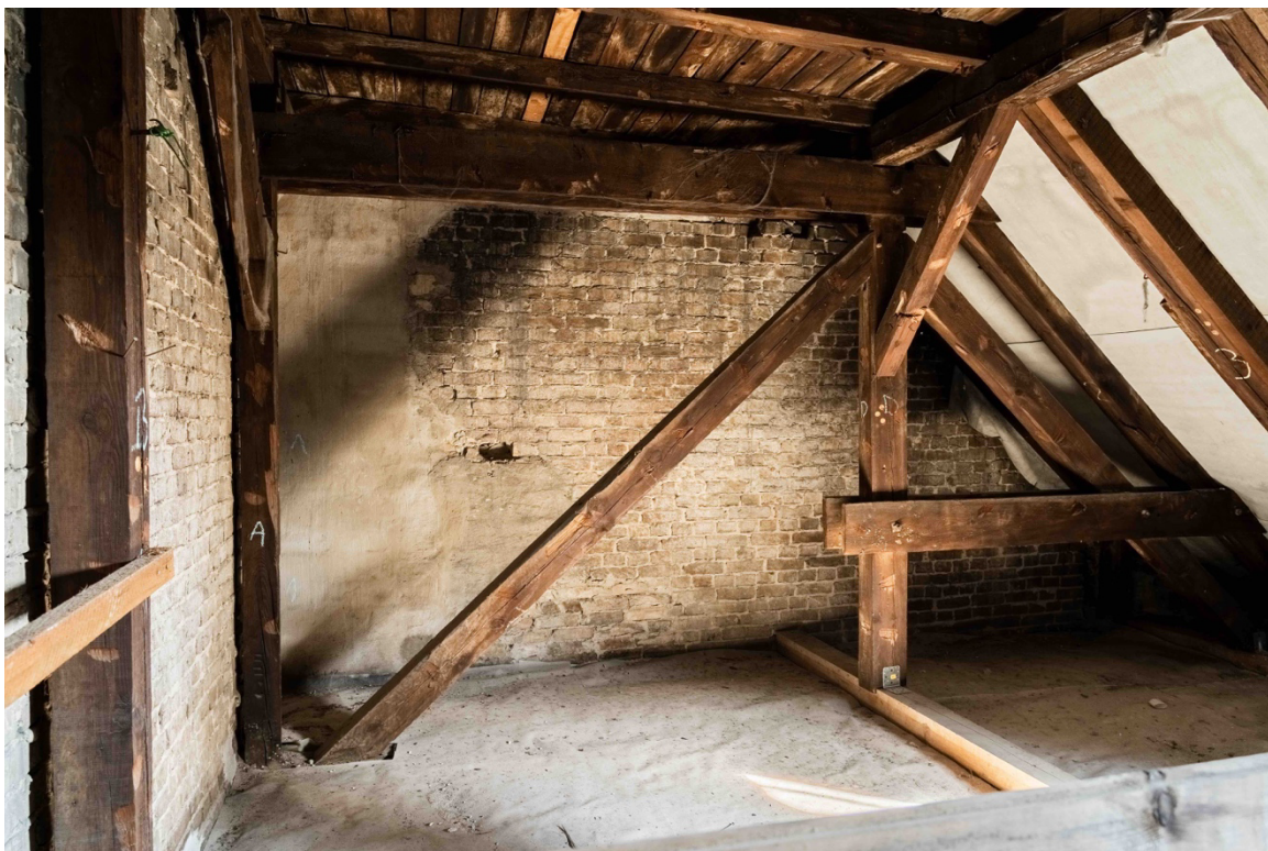
5. OG/ Dachgeschoss - Foto des aktuellen DG-Kaltdach-Rohlings
