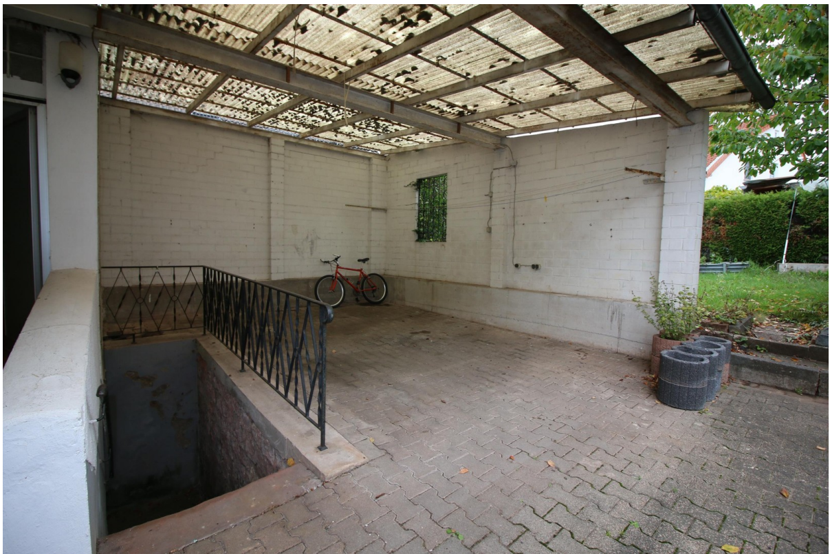
Hof und Zugang Keller
