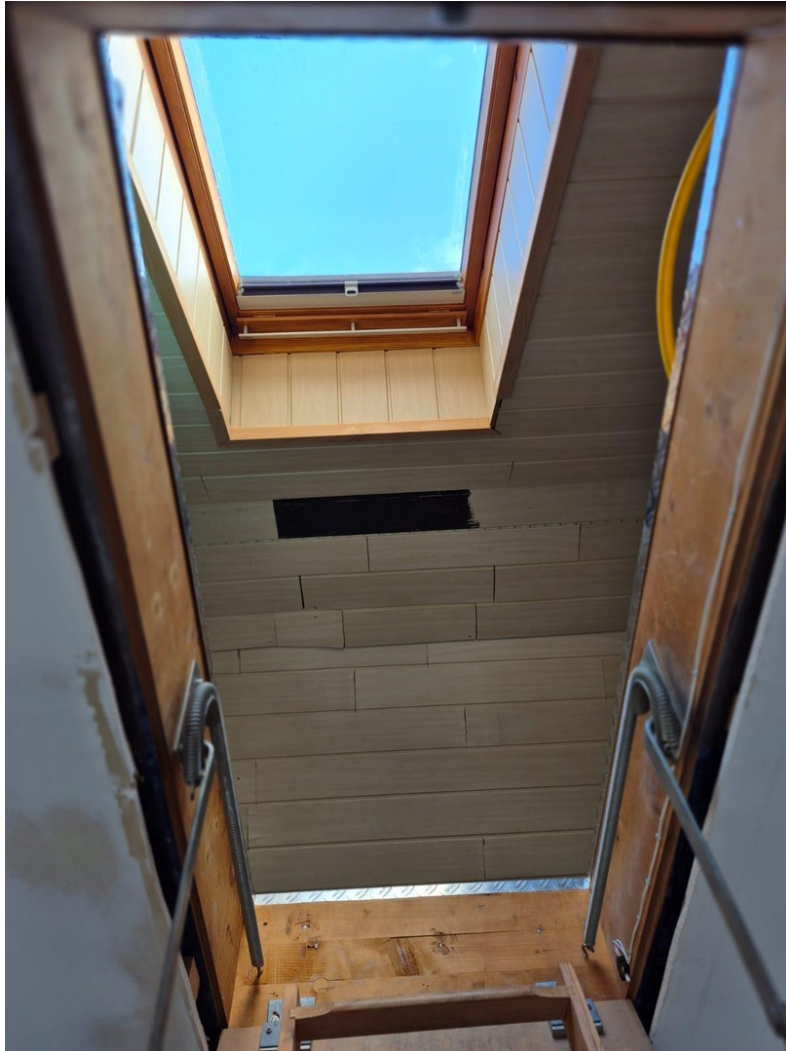
Dachfenster im Spitzboden
