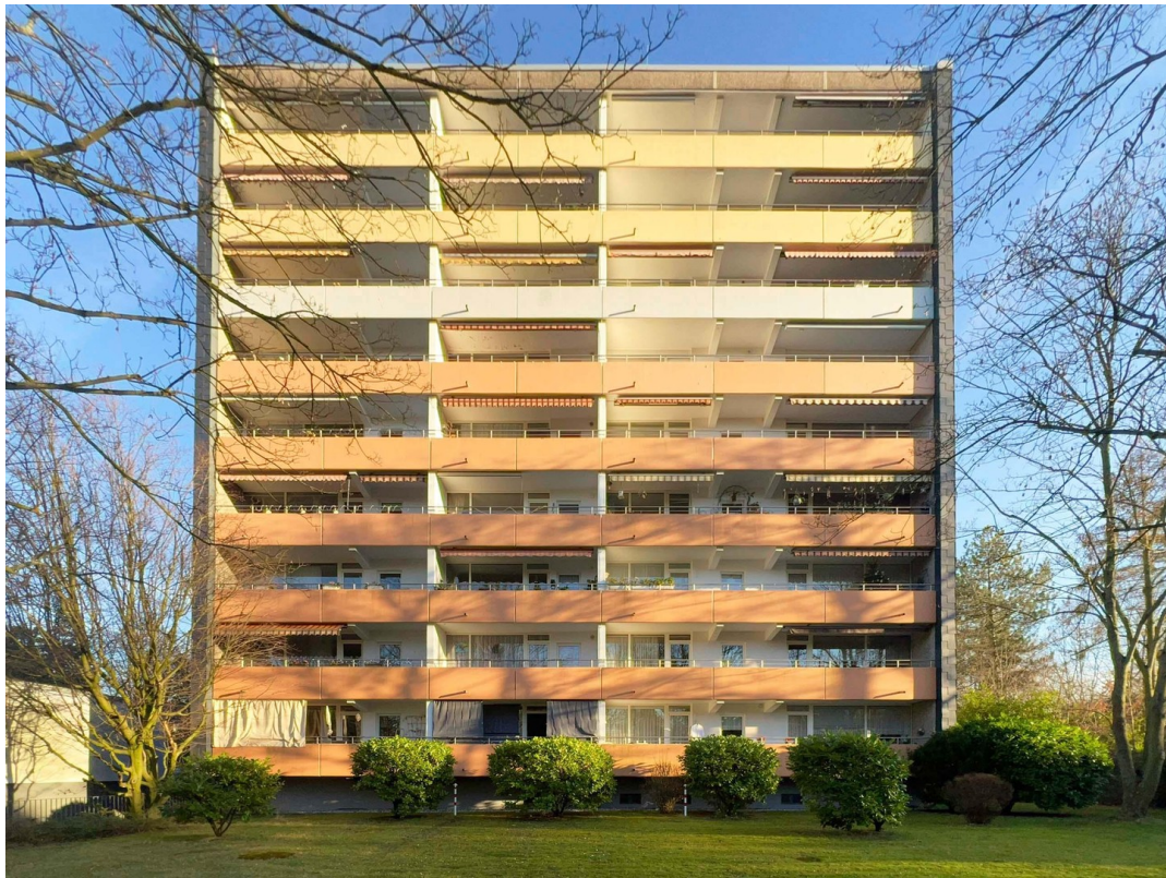
Ansicht Fassade Ostrasse
