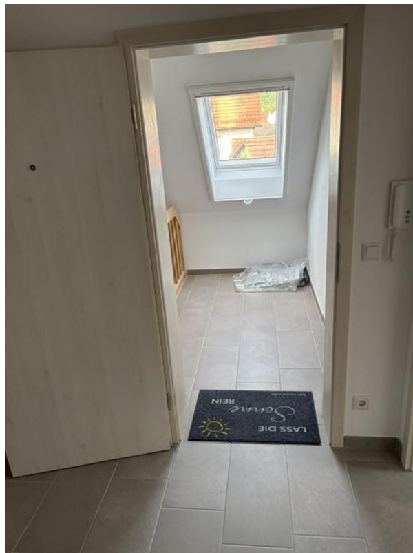
Eingang ETW2 DG leer
