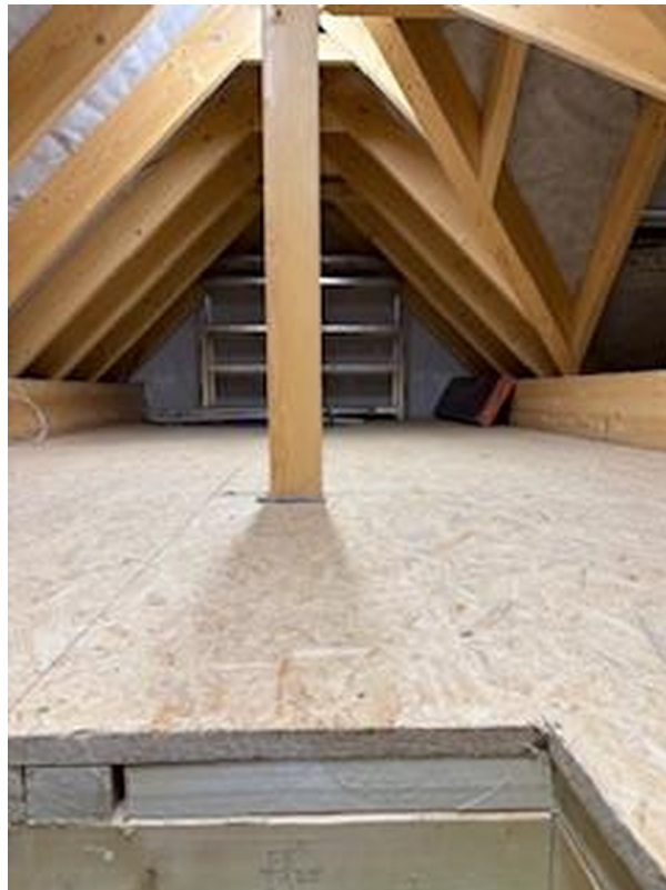
Dachboden Südseite ETW2
