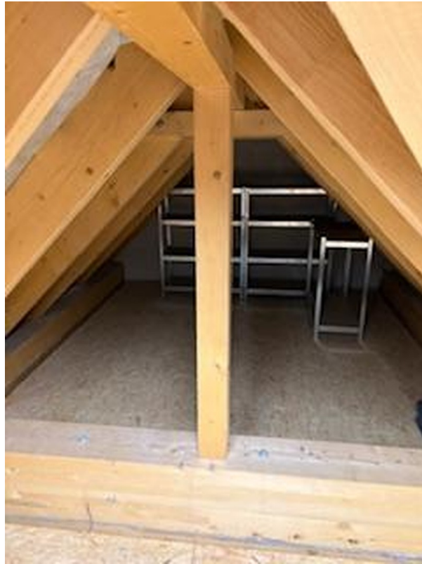
Dachboden Westseite ETW2
