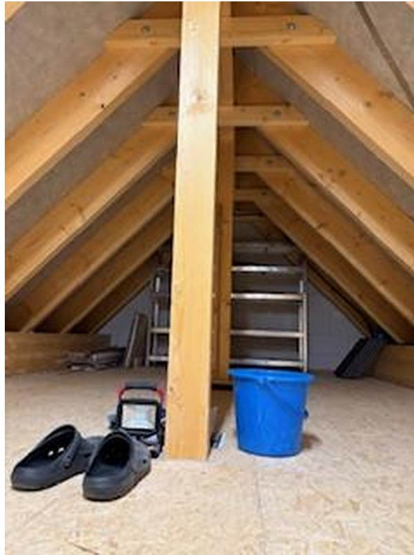
Dachboden Nordseite ETW2
