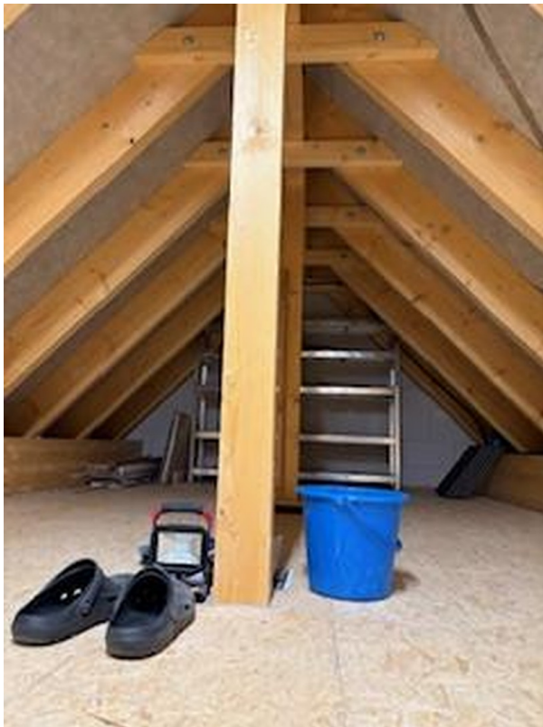
Dachboden Nordseite ETW2
