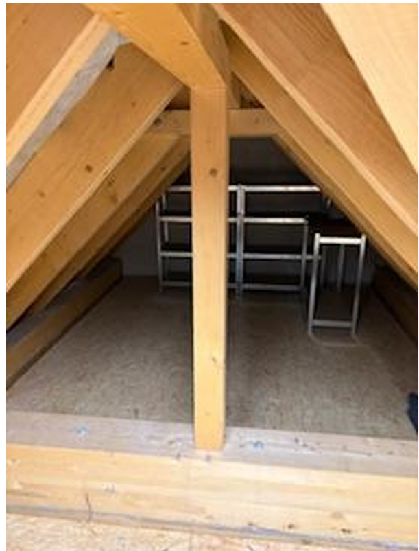
Dachboden Westseite ETW2
