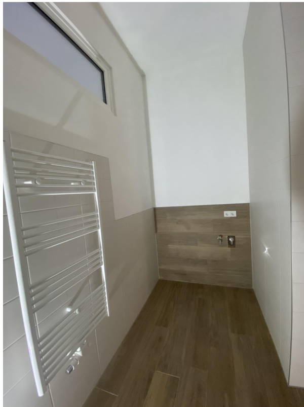
Waschmaschinenanschluss
