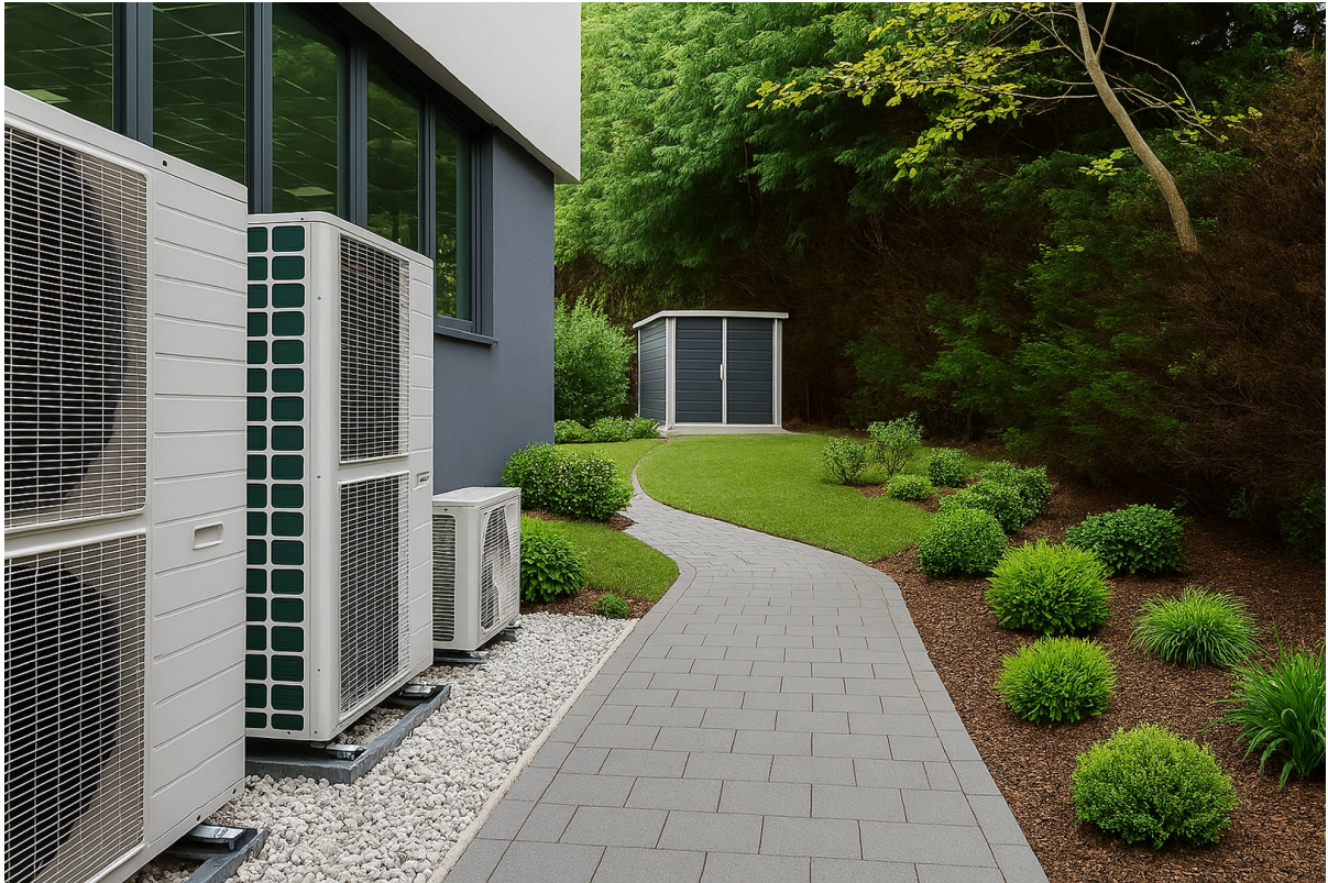
Außenanlagen mit Wärmepumpen
