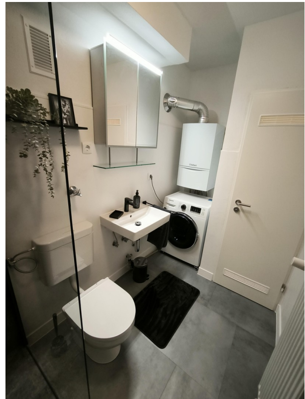
Bad / Waschtrockner / Heizung
