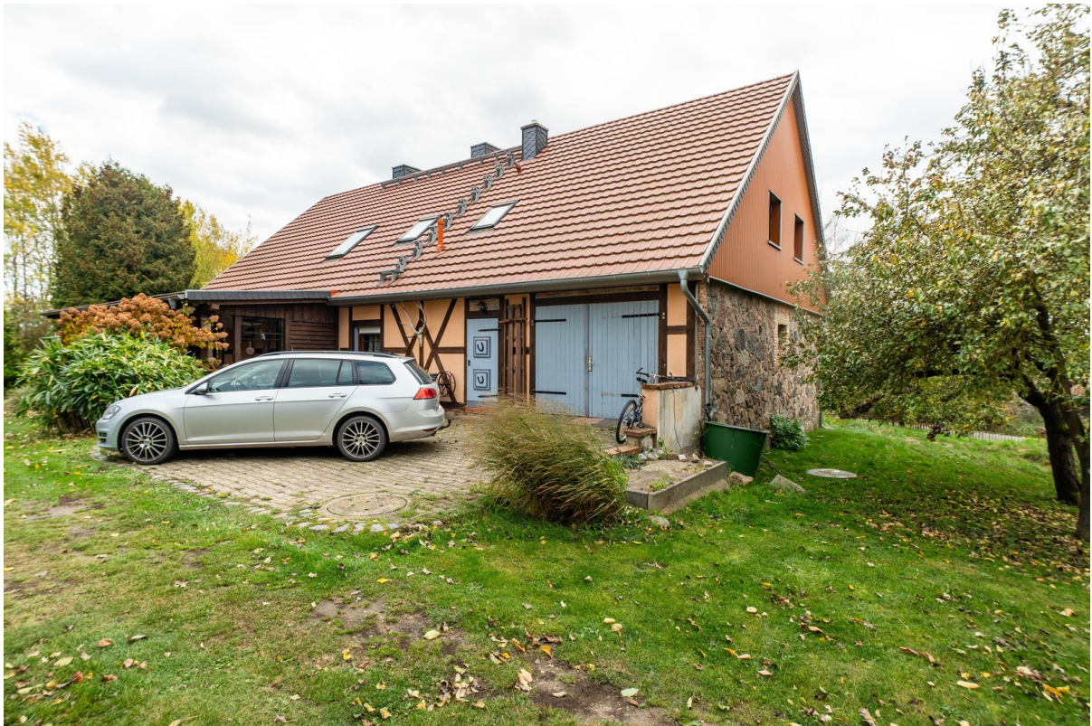
Ansicht mit Garage
