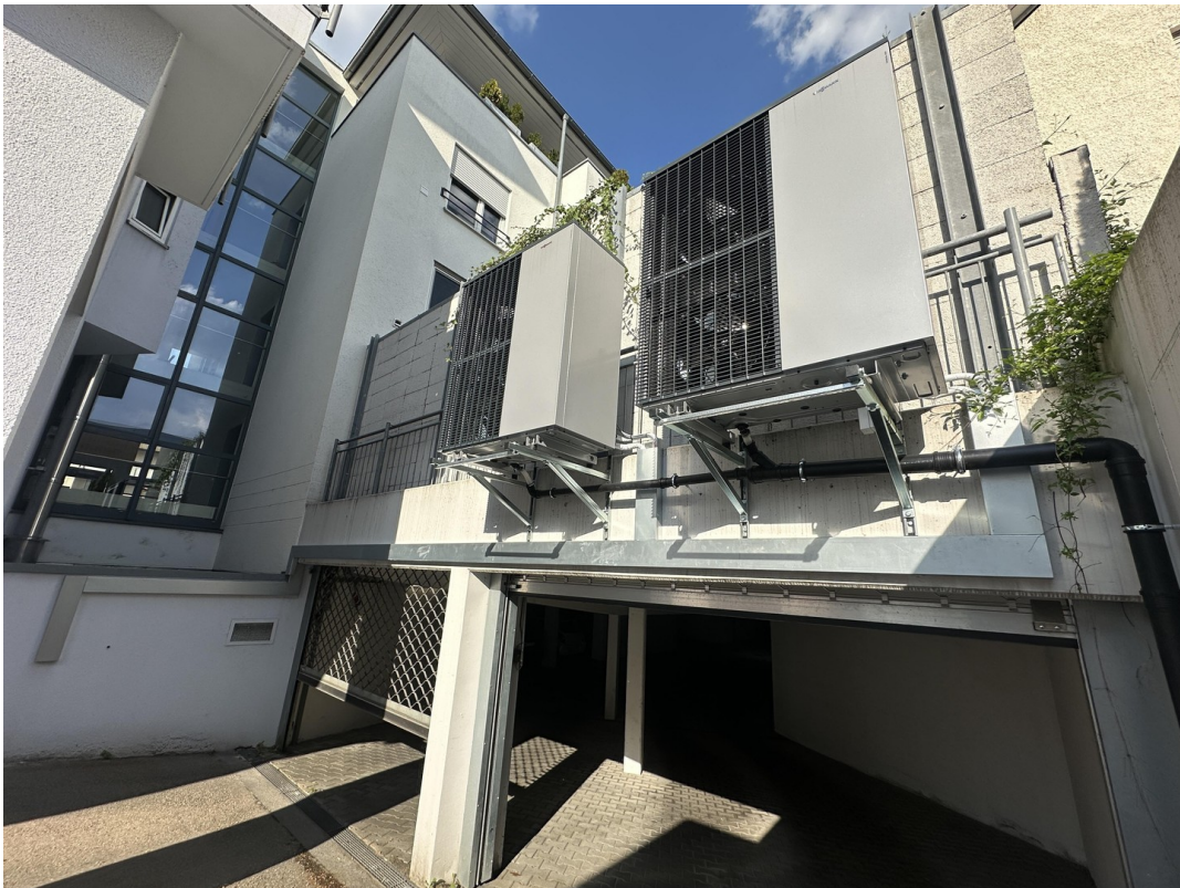
Wärmepumpe außen
