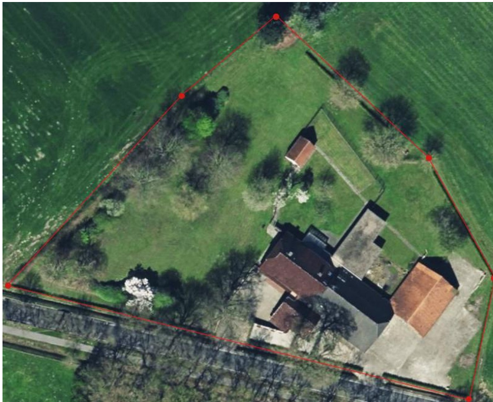
Übersicht Grundstück komplett
