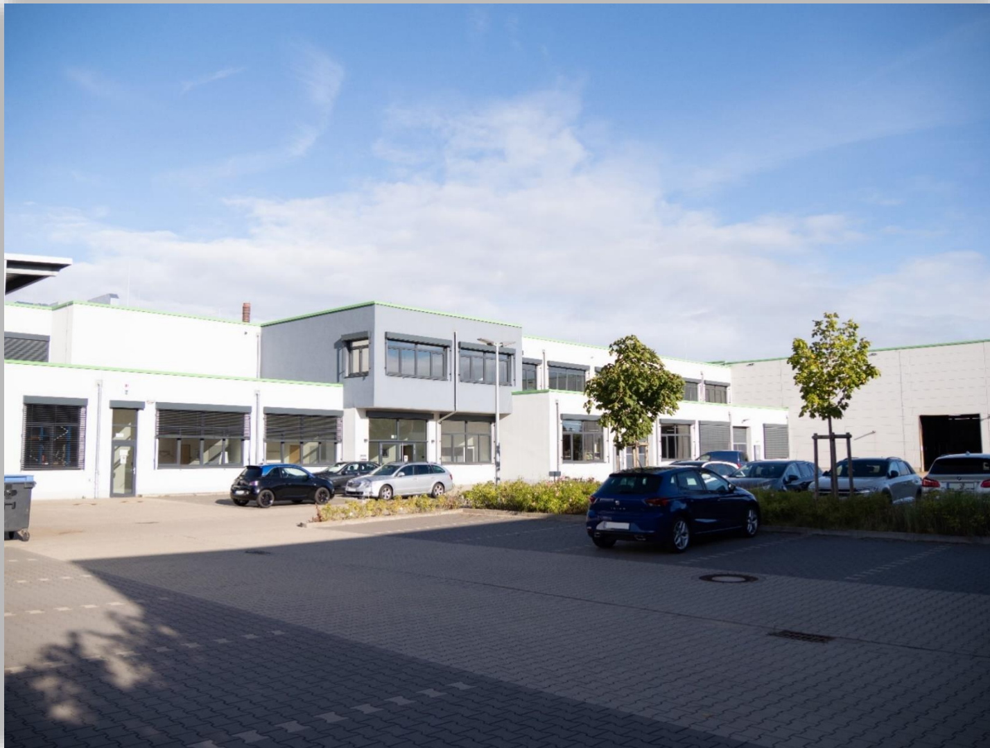
Abb. 18 - Außenbereich mit Parkmöglichkeiten
