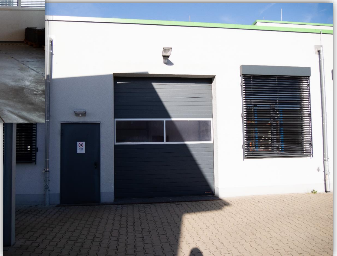
Abb. 15 - Lagerhalle / Versand außen
