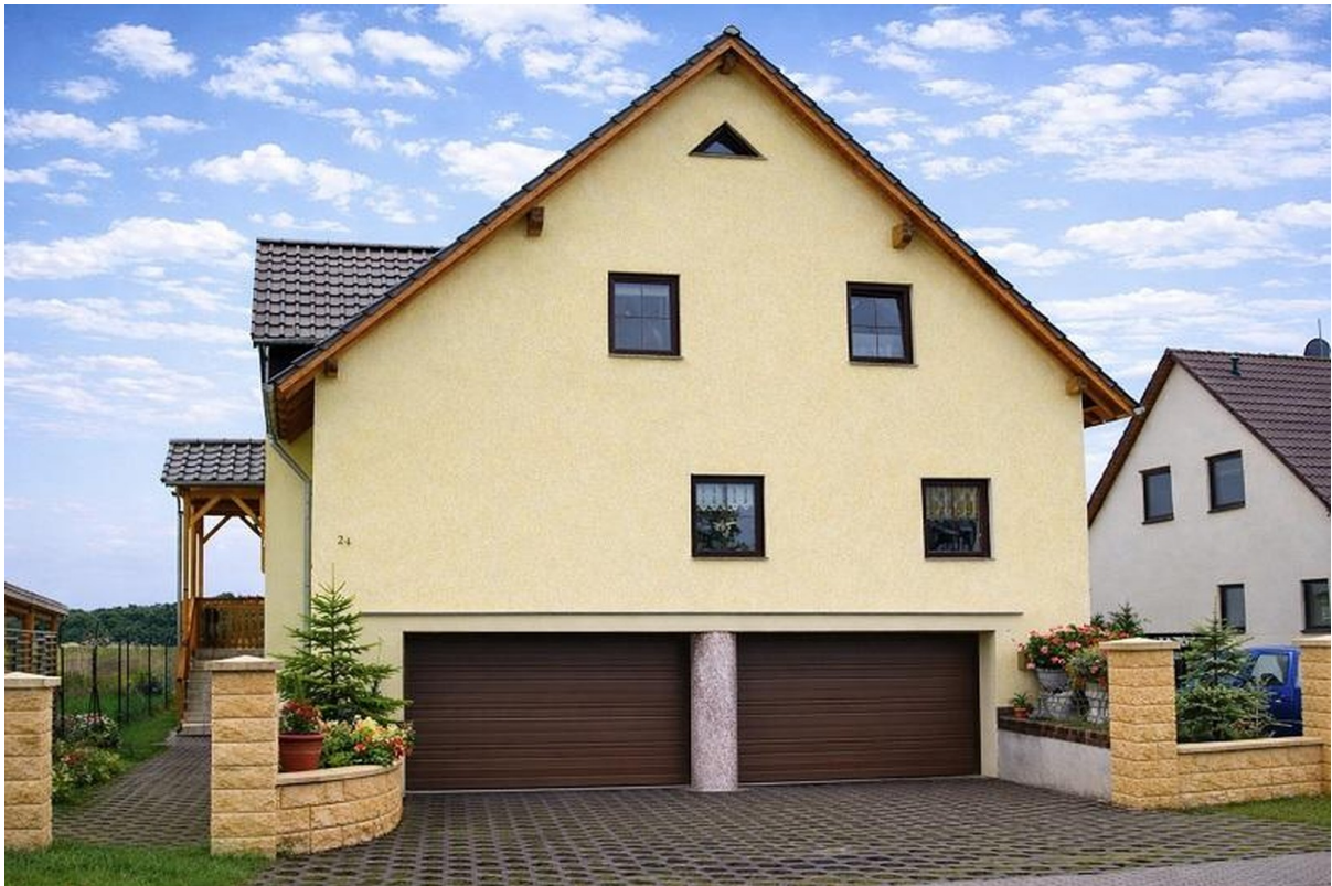
Haus mit Einfahrt TG
