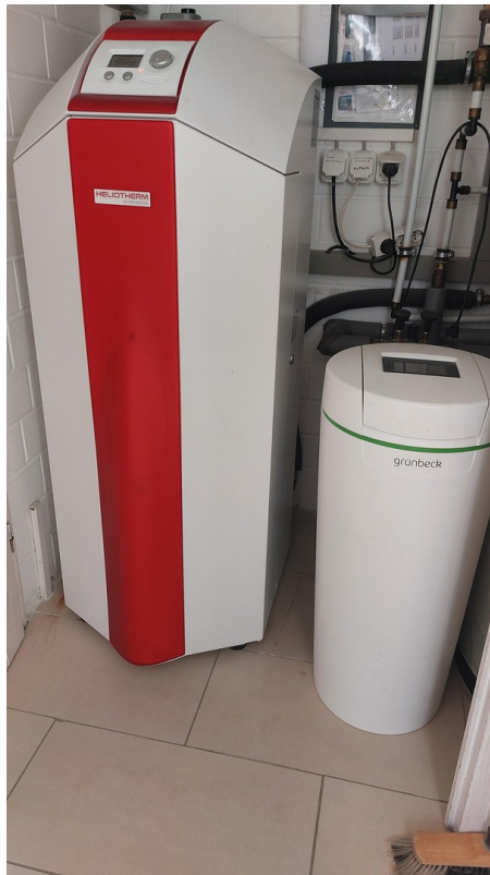
Wärmepumpe, Entkalkungsanl.
