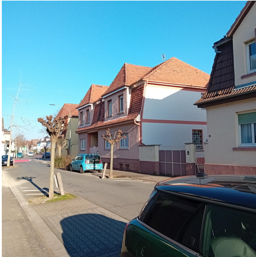
Gedäudeansicht zur Strasse
