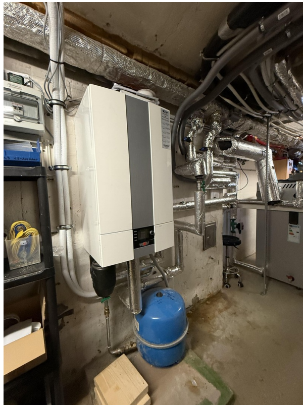
Innengerät Luft-Wärmepumpe
