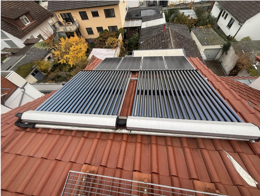
Solarthermieanlage
