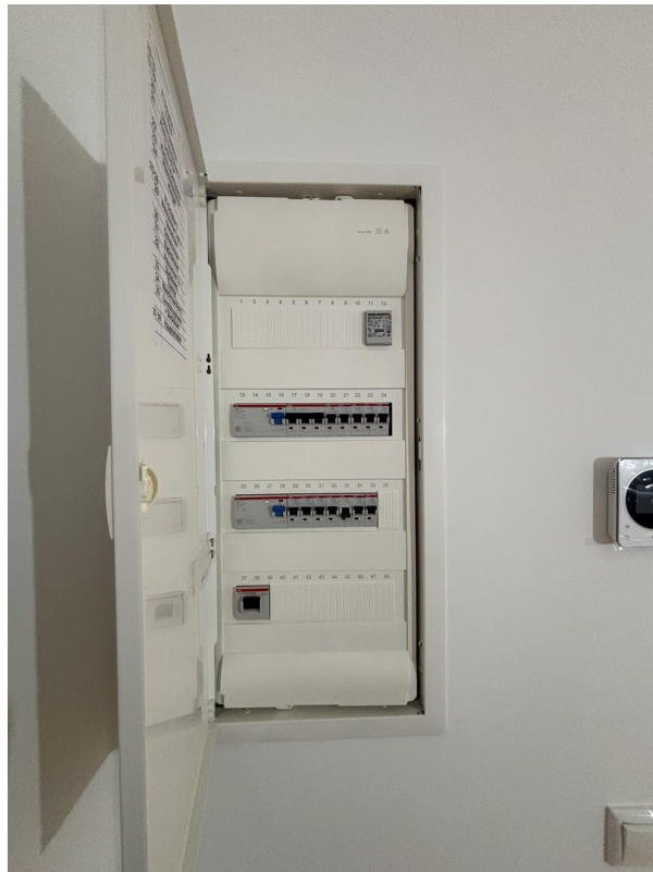
Vollständig neue Elektrik
