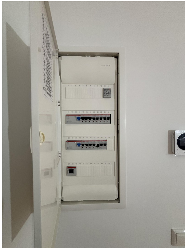
Vollständig neue Elektrik
