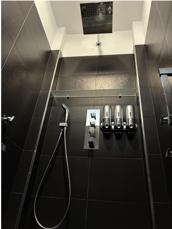
Bad OG - Dusche
