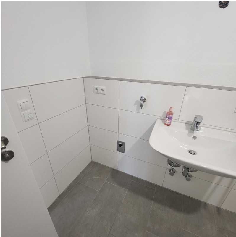
Waschmaschinenanschluss
