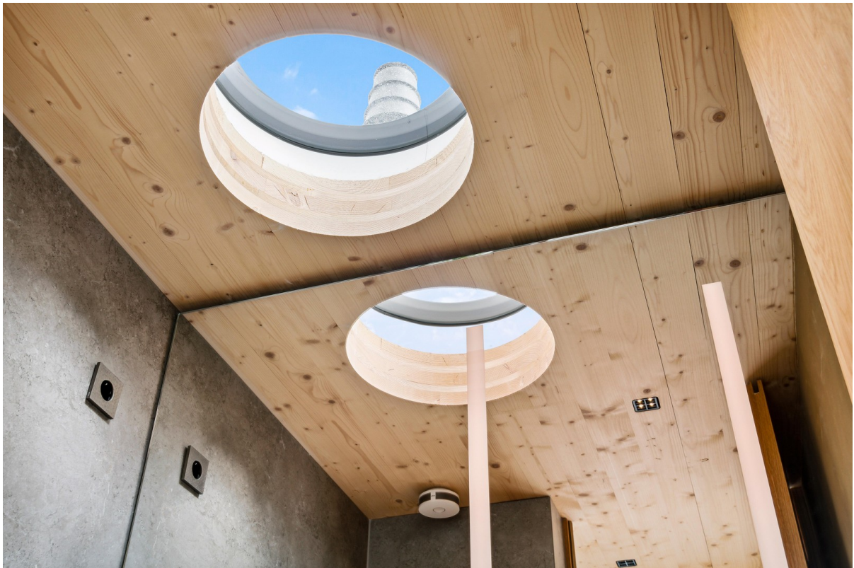
Tageslichtfenster im WC
