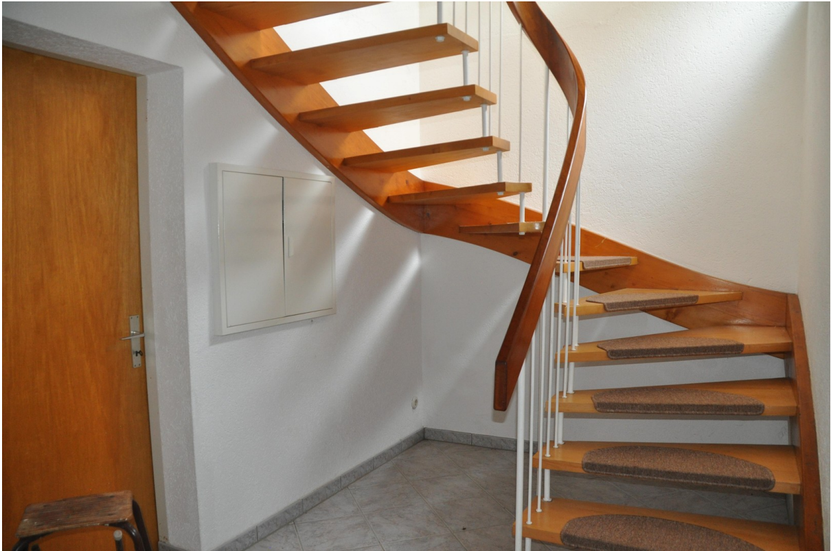
Treppe von EG ins UG
