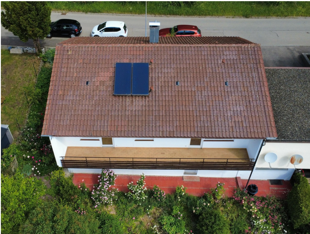
Solarthermie auf dem Dach 2013
