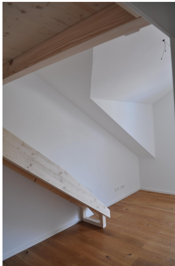
Deckenhöhe unter Balken 204 cm
