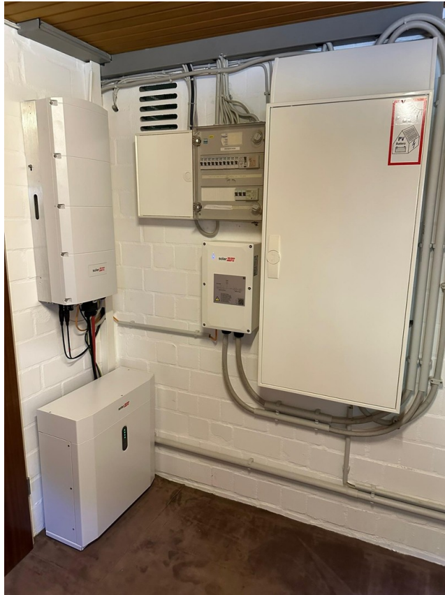
Wechselrichter und Backup PV
