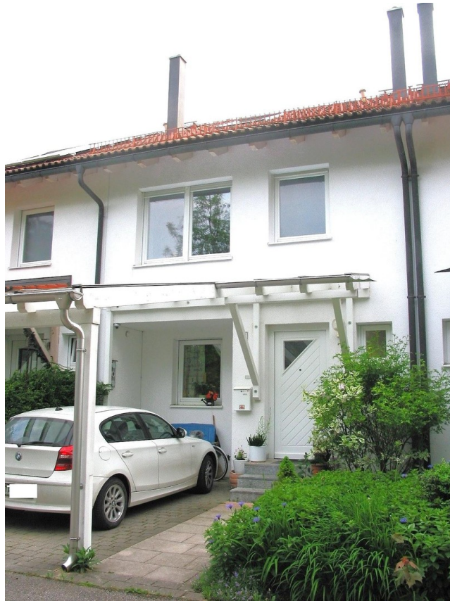
Eingangsseite mit Glascarport
