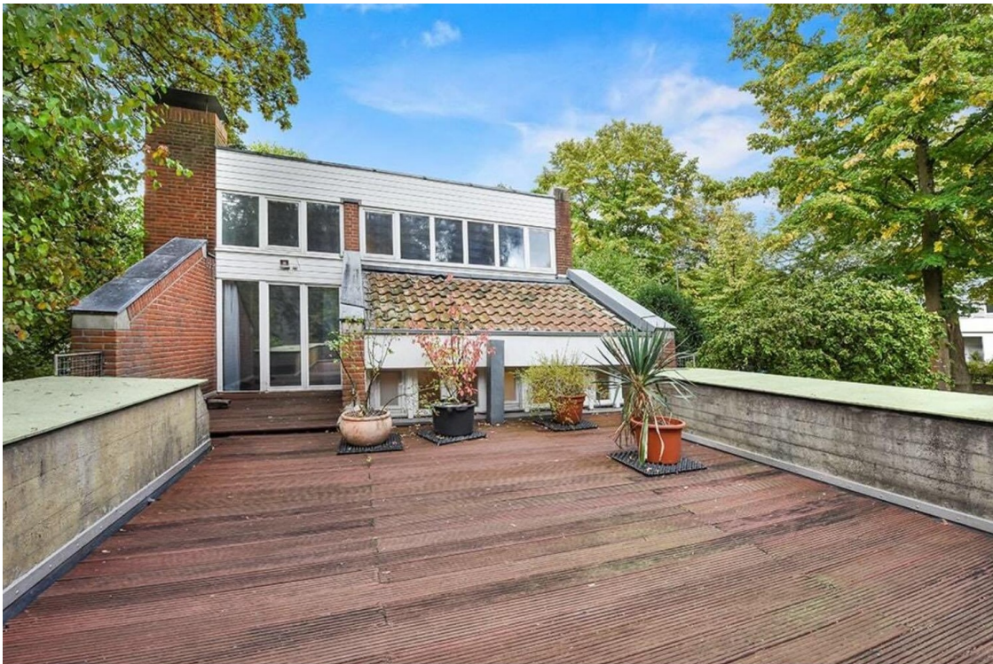
Dachterrasse Gästehaus Dachterrasse
