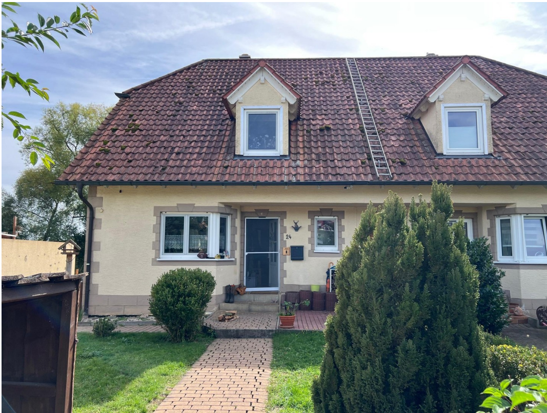
Nordansicht / Eingang (EG)
