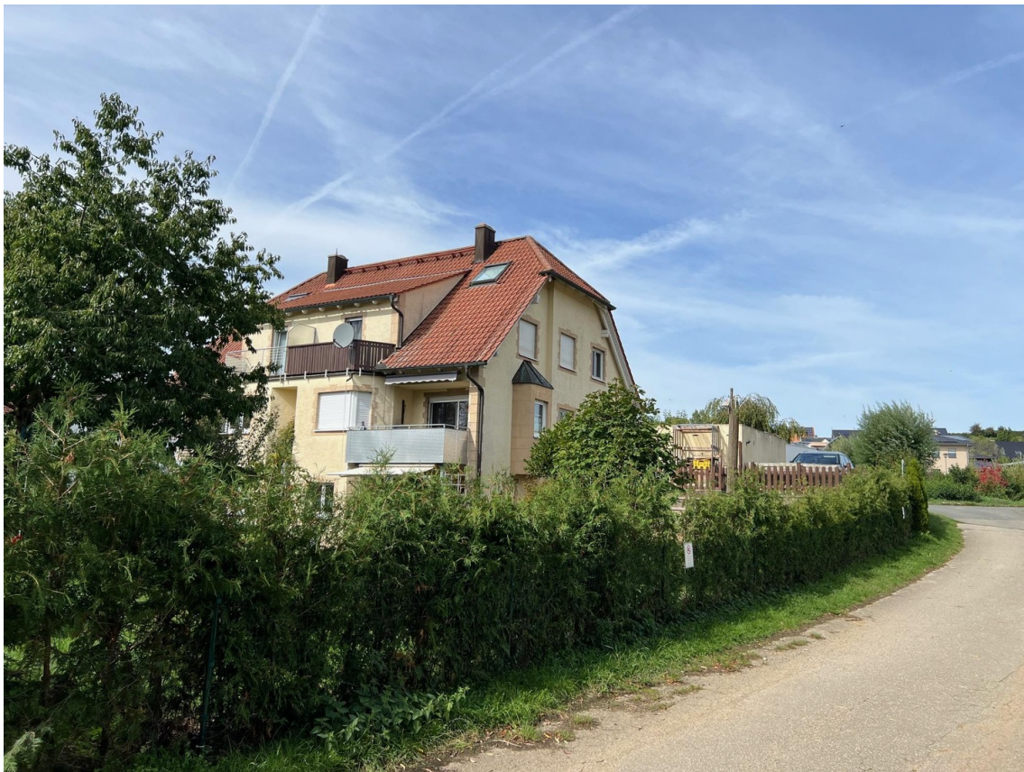
Südsicht (auf der Flur)
